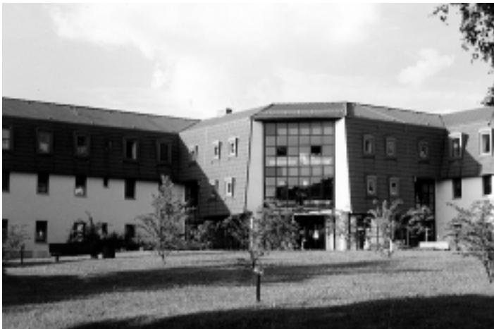
Neubau der „Friedenshöhe“ Radeburg
