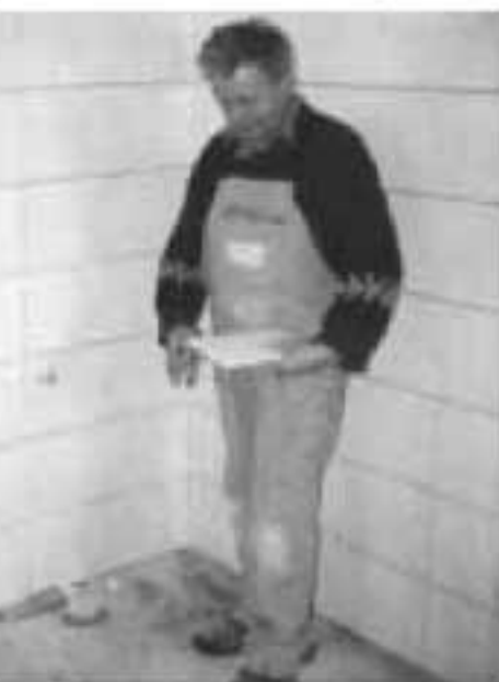
Fliesenlegearbeiten in den neuen Waschräumen der Kinderkrippe
