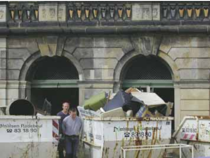
Vier Container füllten sich beim Arbeitseinsatz der Freunde des Museums Schloß Moritzburg mit Sperrmüll und Bauschutt.
