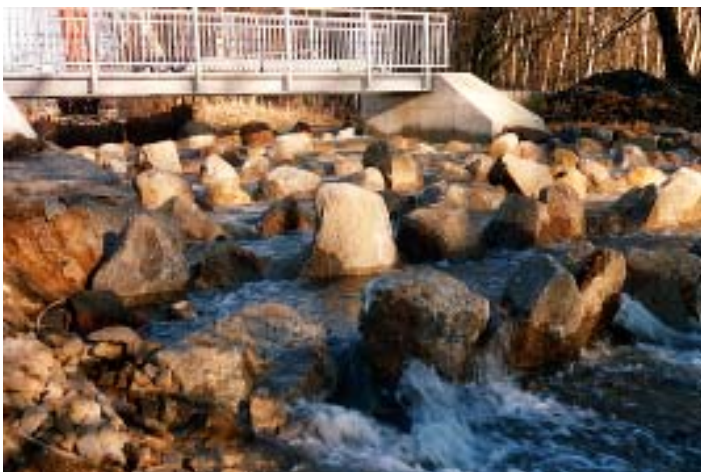
Das Paulsmühlenwehr mit Fischtreppe am Tage der Übergabe am 15.02.2002 ( Foto: Lösche)
