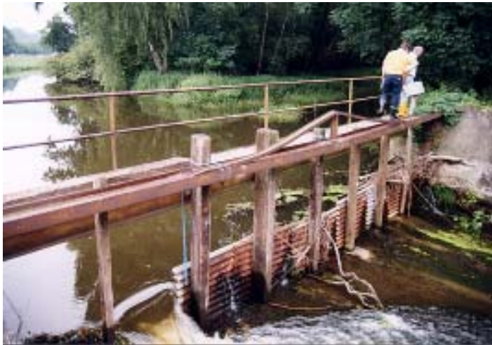
Das Wehr vor der Baumaßnahme im September 2001 (Foto: Findeisen)
