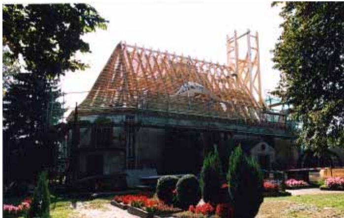
Der neue Dachstuhl mit Turmsäulen wirkt prächtig
