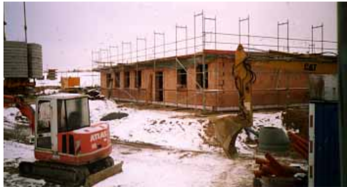
Trotz der winterlichen Temperaturen ist ein Baufortschritt am Pflegeheimneubau in Schönfeld sichtbar.
