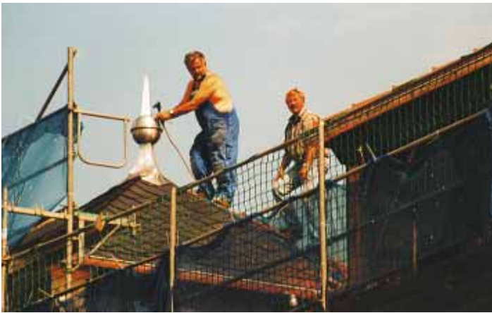
Mitarbeiter Klaus Fay und Klempner- und Installateurmeister Siegfried Herrmann setzen dem Haus eine Turmspitze auf
