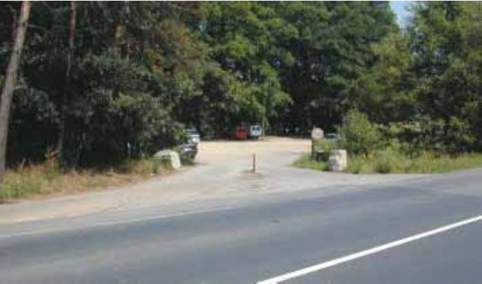
Irreführende Poller in der „Fahrbahnmitte“, die eigentlich als Abgrenzung zwischen Parkplatzzufahrt und Radweg gedacht sind
