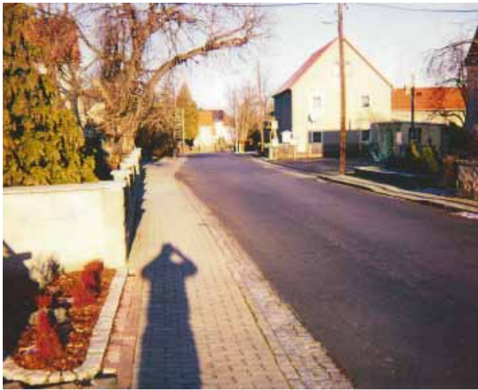
Teilstück der erneuerten Straße im OT Kleinnaundorf
