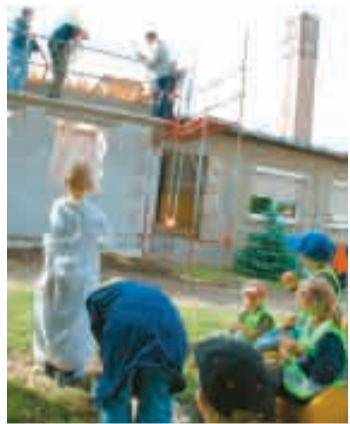
Bürgermeister Dieter Jesse beim Einschlagen des Nagels für die Dachkonstruktion.
