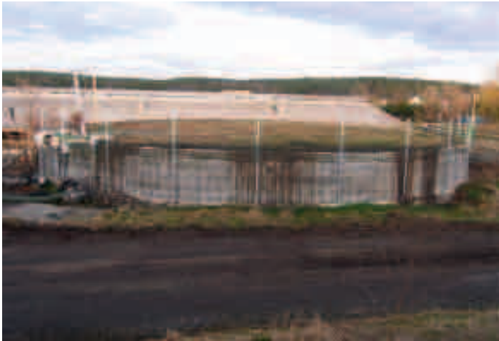
Das darf nicht passieren: Überlaufendes Güllebecken
