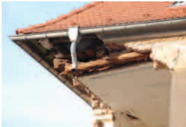
Eine Schadensursache könnte Durchfeuchtung des Mauerwerkes an einem fehlenden Fallrohr gewesen sein, der Zustand der Bausubstanz an dieser Stelle spricht aber eher gegen diese Annahme.
