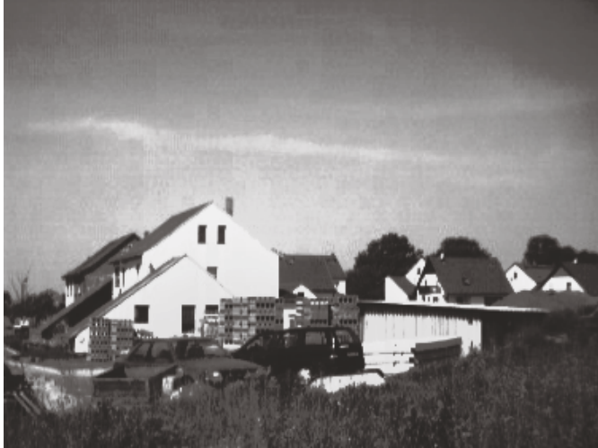
Auch in Naunhof wird viel gebaut
