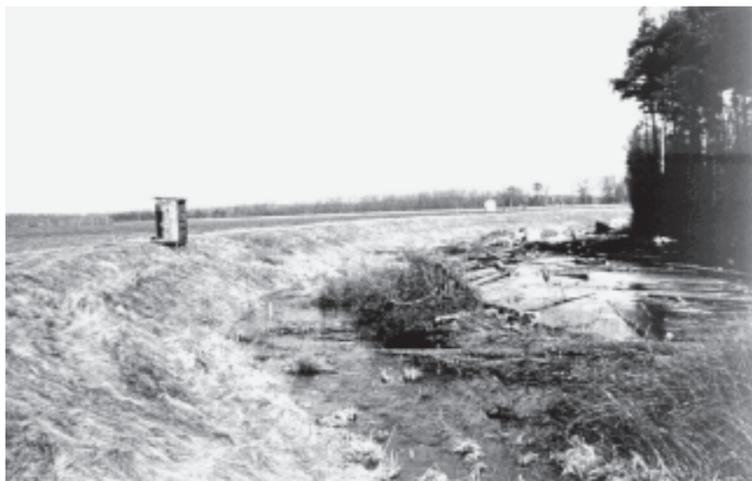
Zustand des Damms bis 1973. Deutlich ist die Unterläufigkeit zu erkennen.
