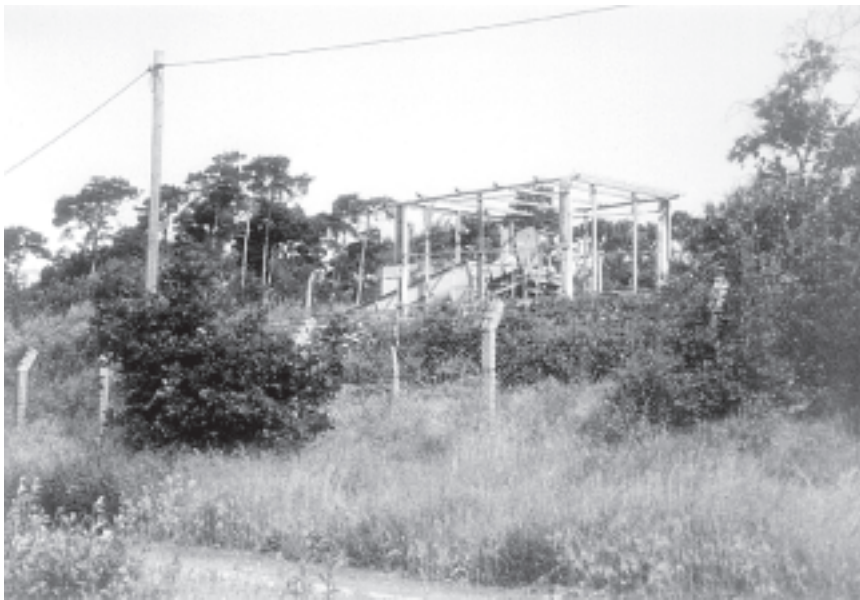
Hauptquelle des Gestanks: Güllestation an der Waldrose
