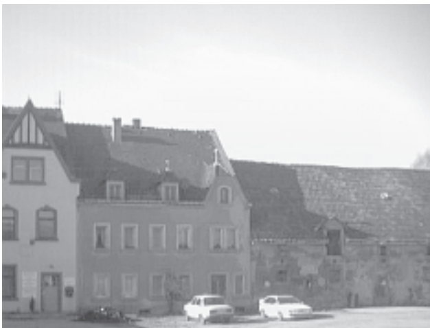
Nur die von der Agrargenossenschaft genutzten Gebäude sind notdürftig saniert.
