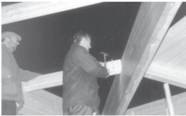
Bauleiter Jens Böhme überläßt dem Bauherren, Mathias Jahn, das Einschlagen des letzten Nagels
