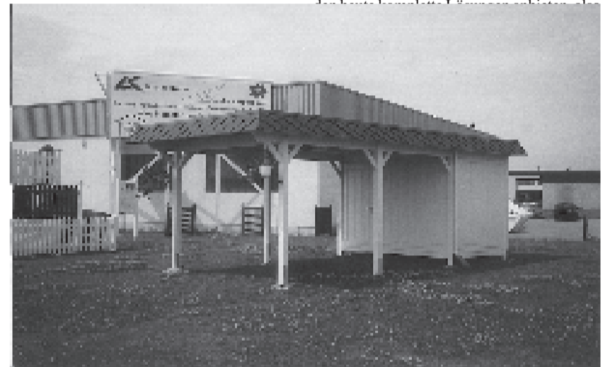
Musterausstellung auf dem Betriebsgelände der Dachdecker Kretzschmar GmbH
