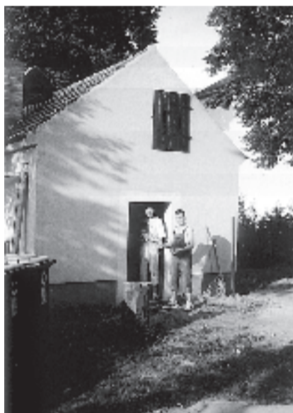
Hier werden demnächst die sanitären Anlagen entstehen
