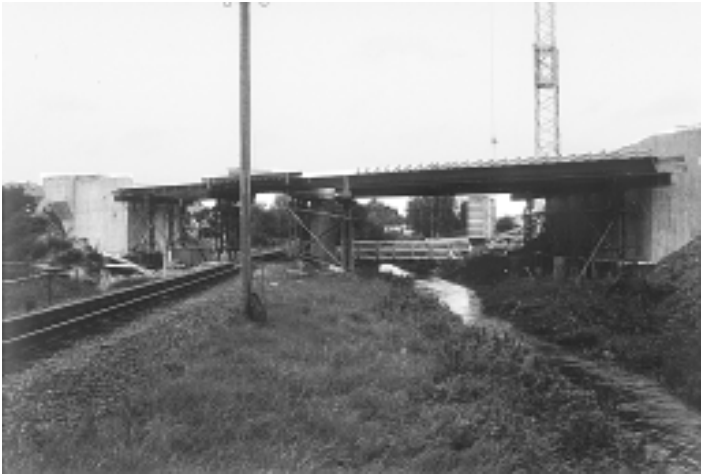
Das Brückenbauwerk über Promnitz und Kleinbahn.
