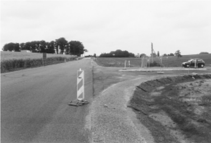
Die Einmündung der Umgehungsstraße in die Meißner Straße ist bereits seit einigen Wochen fertig.
