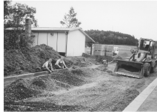
Neuer Weg zum Sportplatz wird gebahnt. Viel Zeit wird noch vergehen, bis alle Arbeiten abgeschlossen sind.
