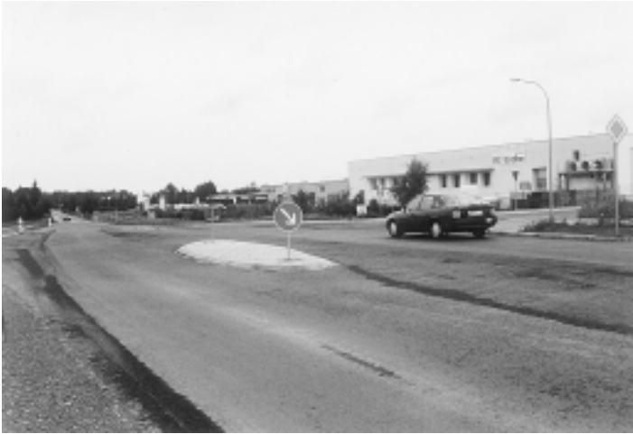
Die ausgebaute Einmündung der Dresdner Straße wurde vergangene Woche wieder für den Verkehr freigegeben.
