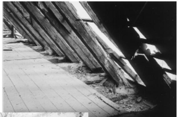
Bild oben: von außen sah das Walmdach zwar imposant aus, aber darunter nagte die Fäulnis.
