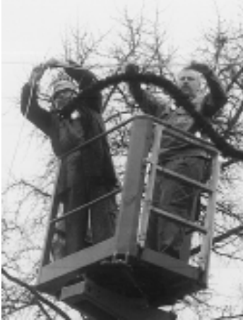
Da geht das Lichtlein an! Die Monteurs des EZG bei den letzten Handgriffen.
