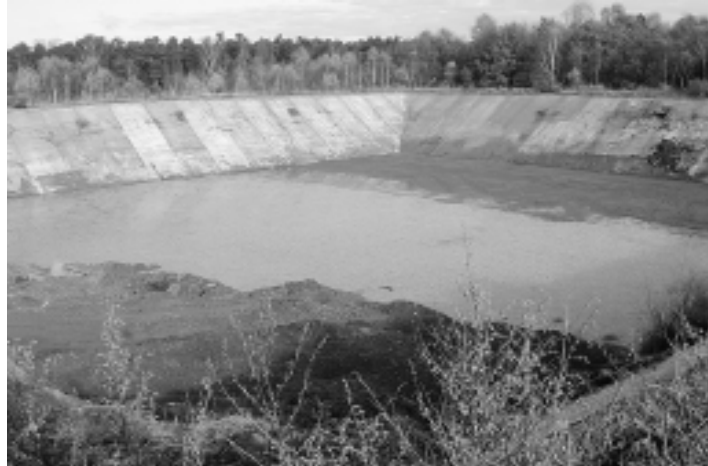
Eines der beiden fast leergeäumten Güllebehälter an der Waldrose
