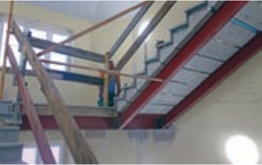
Eine komplett neue Treppe verbindet nun das 2. OG mit dem Dachboden.
